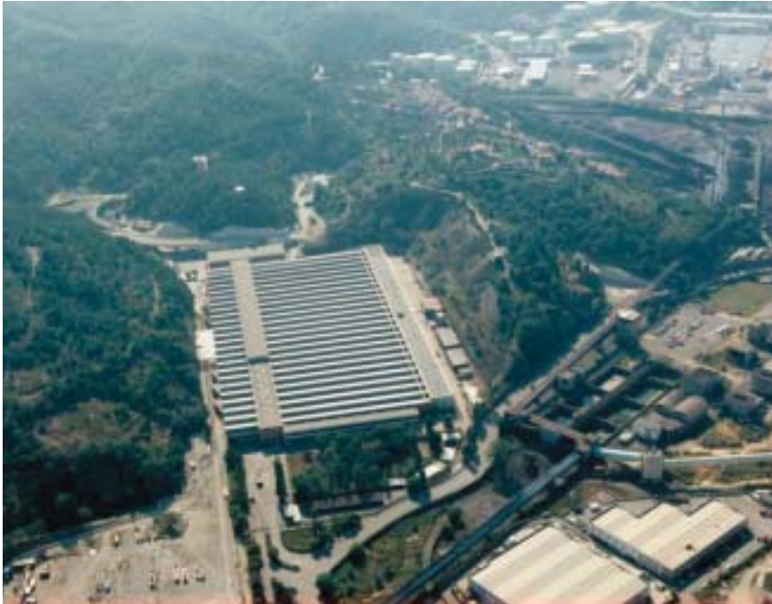
Figura 8 Vado Ligure Interporto V.I.O. Veduta aerea Fonte Autorità Portuale di Savona
