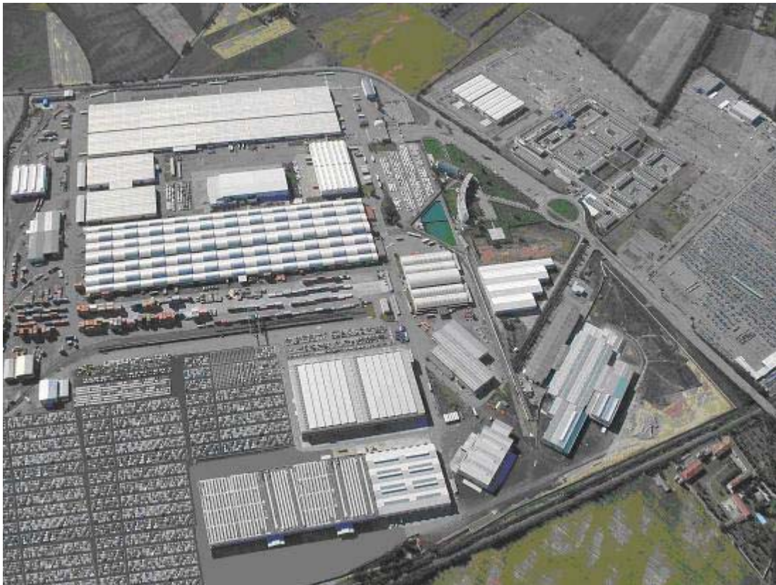
Figura 1 Interporto di Rivalta Scrivia: stato attuale. Fonte www.rivaltalogistica.it
