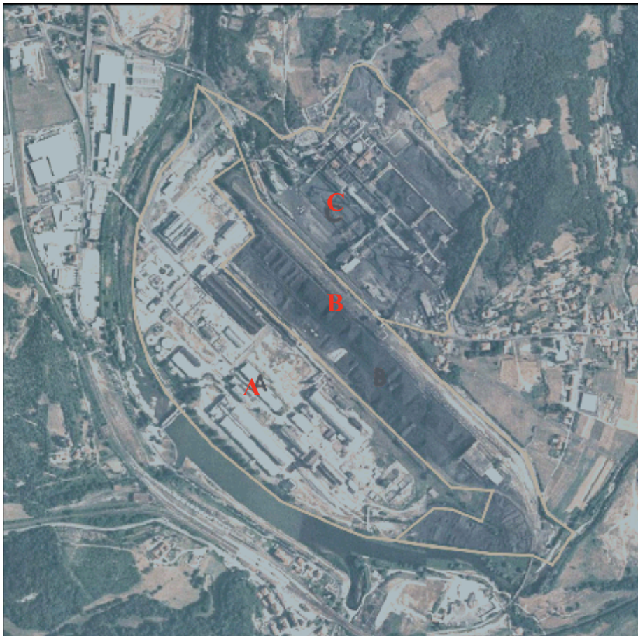
Figura 12 Cairo Montenotte Aree di Bragno, veduta complessiva
