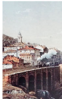
ÉPOQUE La galleria dei Giovi e la stazione di Serravalle
