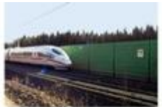
Lärmschutzwand als Standardausführung in Streckenabschnitten ohne besondere Anforderungen
